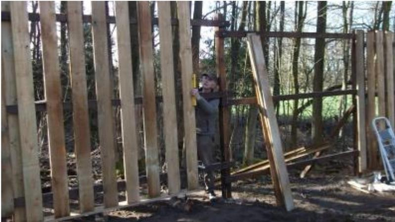
Im Zusammenhang mit dem Bau der neuen Schutzwand wurde auch gleich das Gelände mit Muttererde aufgefüllt und damit der seitliche Höhenunterschied minimiert.
